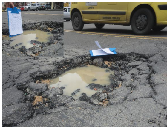
Carrera 41 A con calle 3 – Localidad de Puente Aranda, se detecta un hueco que afecta la estructura en una parte del segmento vial, afectando la movilidad.
