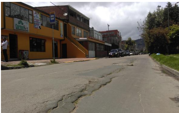
Calle 127 D carrera 52 – Localidad de Suba, deterioro por hundimiento y pérdida de horizontalidad de la calzada que afecta la estructura impactando negativamente la movilidad.
