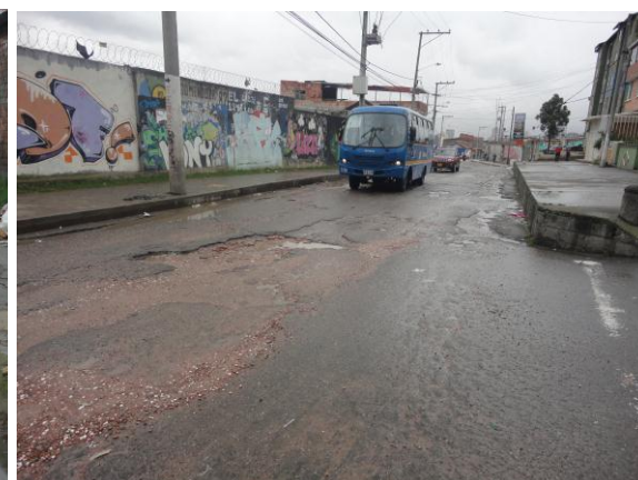
Carrera 3 calle 1. Destrucción total de la estructura – hace parte del corredor de movilidad.
