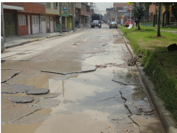
Carrera 80H - Calle 54A Sur localidad de Kennedy losas del pavimento rígido fracturas y destruidas afectando su estructura y la movilidad del sector.
