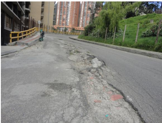
Calle 60 A con carrera 3 – Localidad de Chapinero, se presenta hundimiento de la banca, con afectación de la estructura, por esta vía circula la ruta especial del SITP. Vía intermedia
