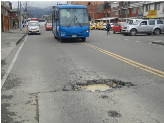
Carrera 41 A con calle 3 – Localidad de Puente Aranda, se detecta un hueco que afecta la estructura en una parte del segmento vial, afectando la movilidad.
