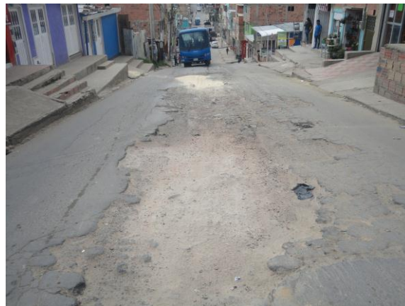
Calle 71 H carrera 27 J – vía en pésimo estado que presenta deterioro de la estructura que afecta la movilidad
