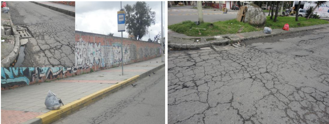
Transversal 28 con carrera 24 – Localidad de los Mártires, vía que afecta lo carpeta presentando fisuras y grietas longitudinales y transversales en bloque sobre pavimento flexible.
