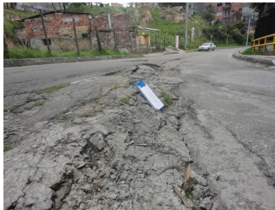
Calle 60 A con carrera 3 – Localidad de Chapinero, se presenta hundimiento de la banca, con afectación de la estructura, por esta vía circula la ruta especial del SITP. Vía intermedia
