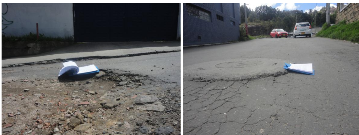
Calle 167D carrera 7, localidad de Usaquén, presenta afectación vial, pérdida de horizontalidad, fisuras y grieta de bloque.
