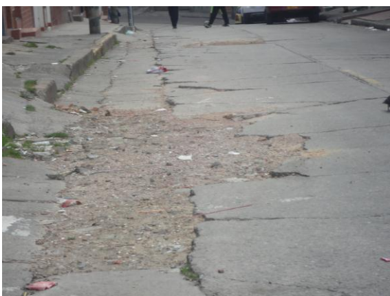
Calle 30 sur carrera 4 este – Localidad de San Cristobal, se observa el deterioro de las placas de concreto afectando la estructura y la movilidad del sector.
