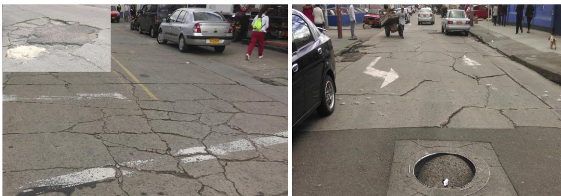
Carrera 15 calle 67 – Localidad de Barrio Unidos, se presenta fisuras y grietas longitudinales y transversales en bloque sobre pavimento rígidos, además de baches.
