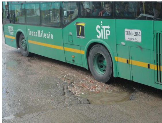
AK 96 con calle 65 – Localidad de Engativá, vía con deterioro de la estructura que afecta la movilidad
